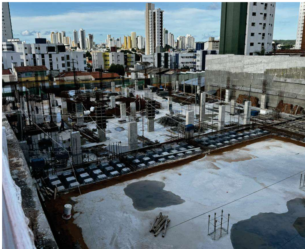
Figura 4. Visão geral dos pilares do segundo subsolo e de parte da laje de cobertura do segundo subsolo.
